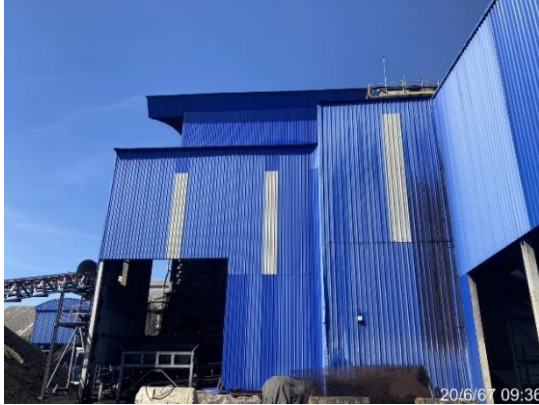
รูปที่ 2-27 โรงคัดขนาดถ่านหิน เป็นแบบปิดแบบสมบูรณ์
