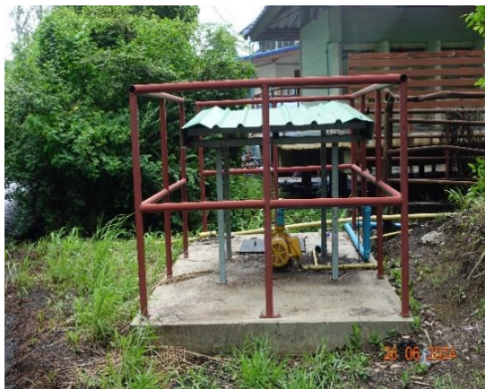
รูปที่ 2-7 บ่อตรวจคุณภาพน้ำทิ้ง ขนาดความจุ 5.67 ลบ.ม.
