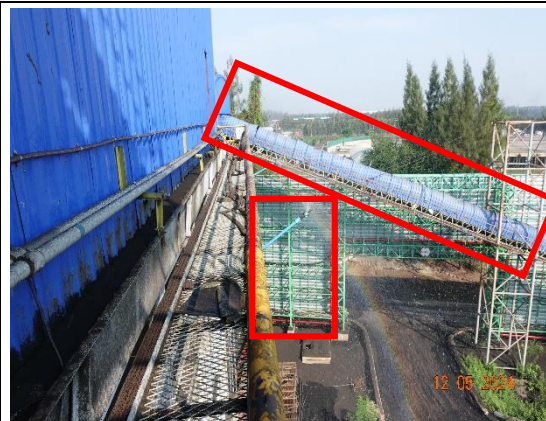
รูปที่ 2-30 สปริงเกอร์ฉีดพรมน้ำ บริเวณอาคารจ่ายถ่านหิน และบริเวณสายพานลำเลียงถ่านหินเข้าสู่โรงคัดขนาดถ่านหิน
