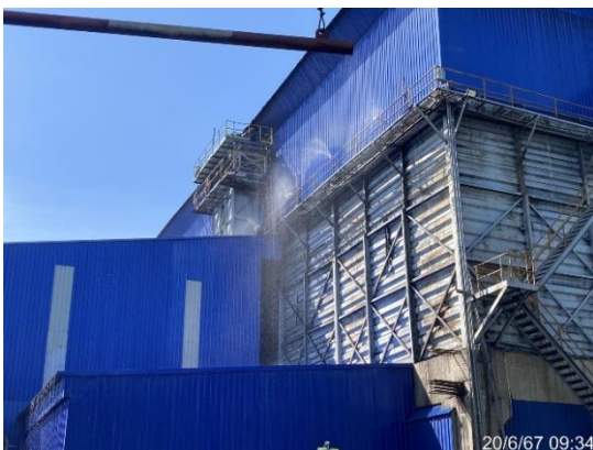
รูปที่ 2-30 สปริงเกอร์ฉีดพรมน้ำ บริเวณอาคารจ่ายถ่านหิน และบริเวณสายพานลำเลียงถ่านหินเข้าสู่โรงคัดขนาดถ่านหิน
